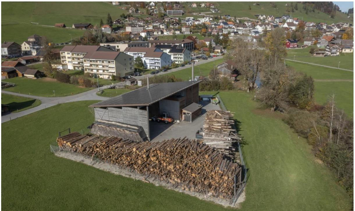
Die Heizzentrale in der Unterdorfstrasse in Urnäsch erzeugt zentrale Wärme für die Gemeinde Urnäsch. Diese gelangt über das mit ca. 80°C heissem Wasser gefüllte Vorlauf-Leitungsnetz zu den angeschlossenen Liegenschaften. Mit Hilfe des Wärmetauschers wird auf der Wärmeübergabestation die Wärme aus dem Fernwärmennetz an den hausinternen Heizkreislauf übergeben. Ab dort fliesst das abgekühlte Wasser im Rücklauf-Leitungsnetz zurück zur Heizzentrale, wo es wieder erwärmt wird.
